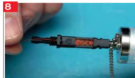
8 Inserire la fibra tagliata nel connettore in modo da vedere la luce rossa nel V-Groove attenuarsi di intensità (questa operazione conferma l'avvenuto dell'accoppiamento delle fibre).
